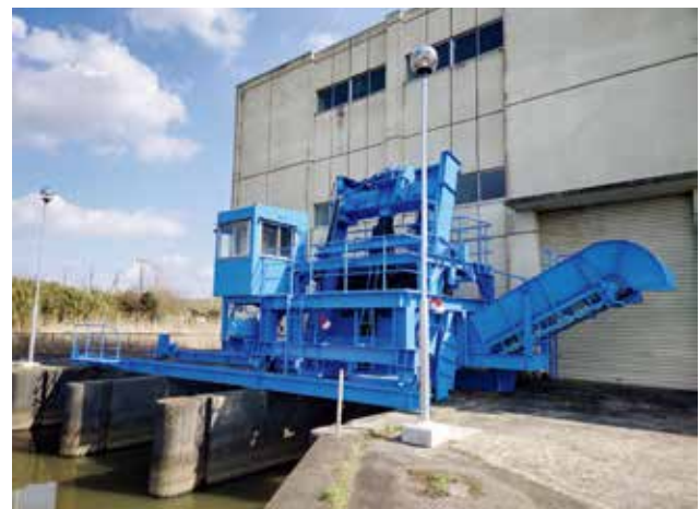
布鎌排水機場
