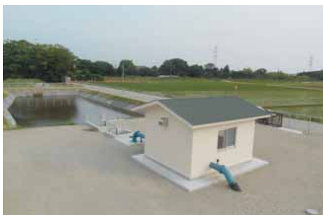
県営利根北部地区第4 機場
