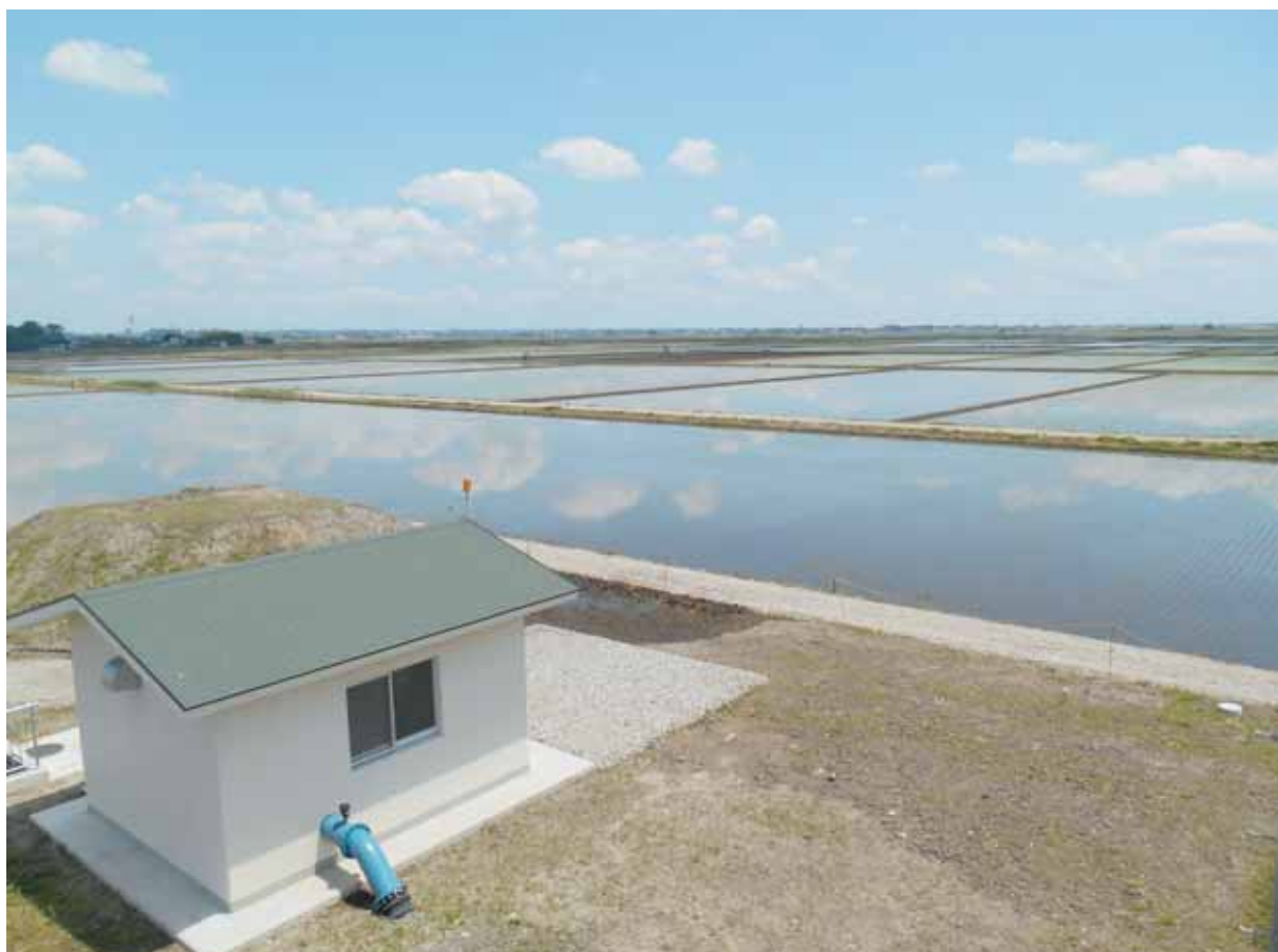
本年四月より耕作可能となった利根町奥山地先・龍ヶ崎市須藤堀地先（手前は利根北部第二機場）
